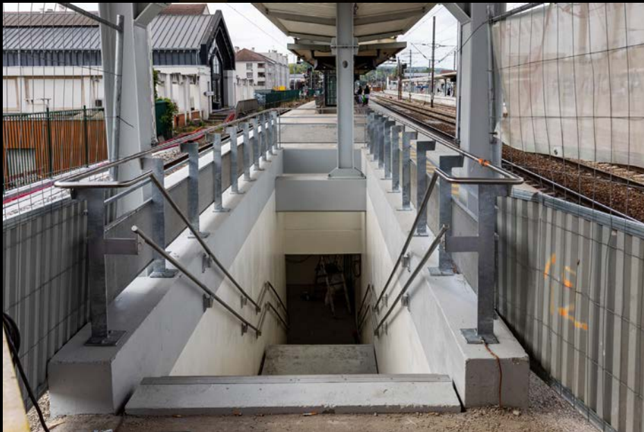
Gare de Poissy / Escalier - Photo
